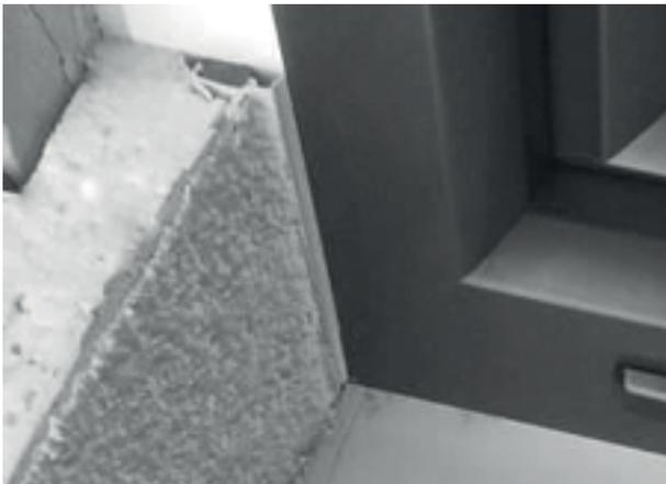
**Abbildung 20:** Fenster mit Vorsatzschale als Halbschale ausgeführt
